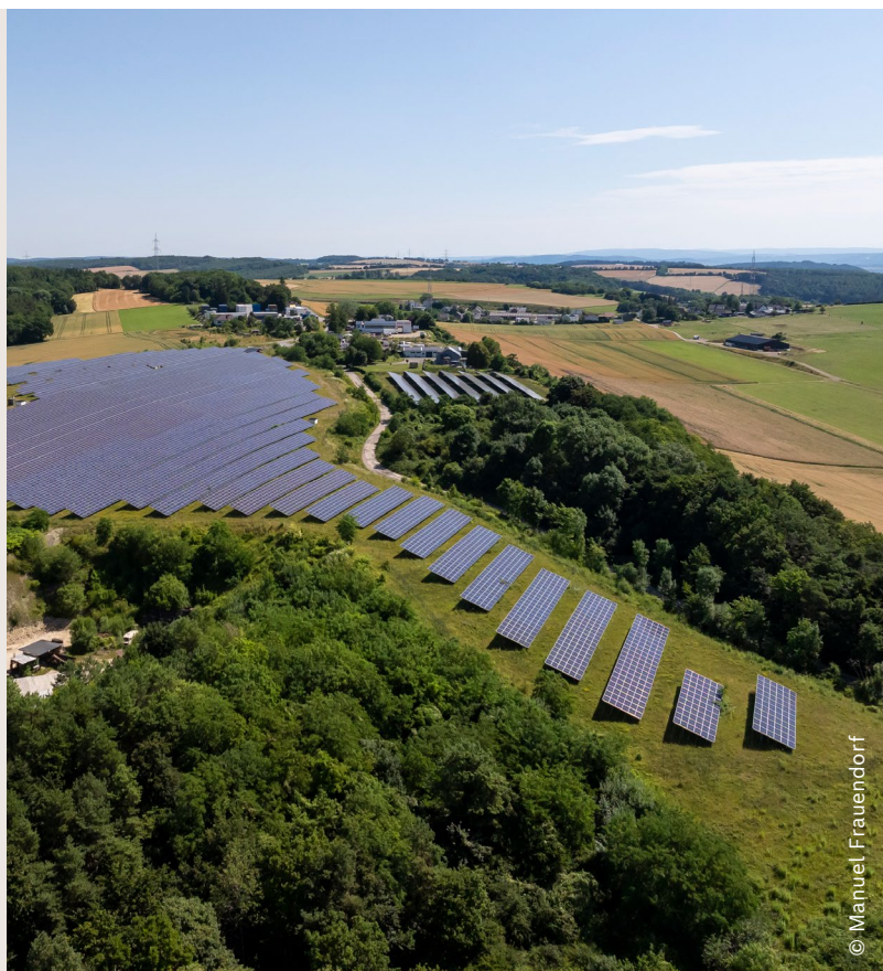
Photovoltaik-Anlage in Ralingen/Kersch
